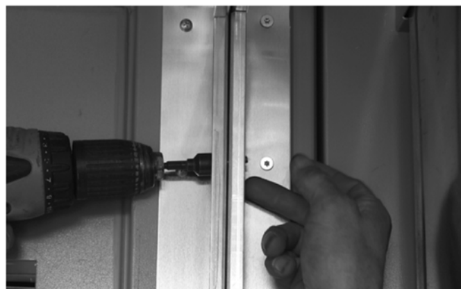
Рис. 22 – Соединение угловых стоек
