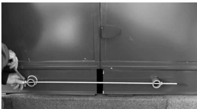
Рис. 14 – Соединение корпусных секций с помощью стержня
